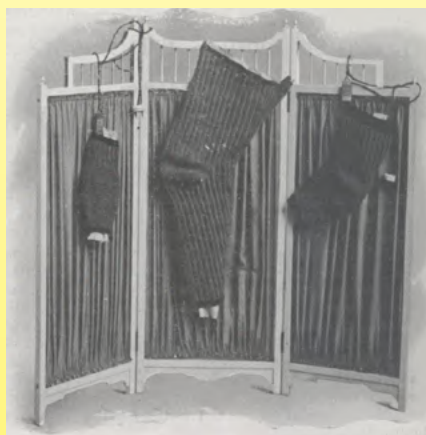
1910 Vêtements chauffants Herrgot à usage médical (Archives d'électricité médicale du 25 Aout 1910). On peut y voir clairement l'existence de nappes de cordes chauffantes cousues.
